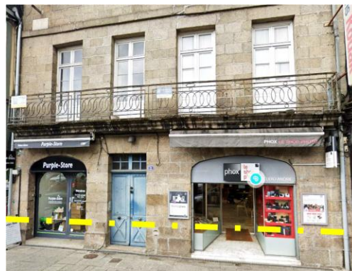
Figure 35 : photographie d'un bâtiment illustrant la configuration principale du bâti en zone inondable
