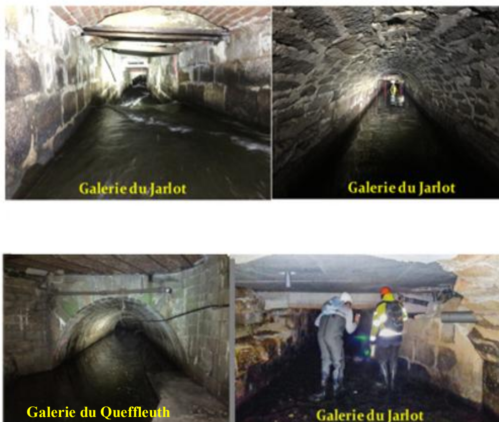
Figure 16 : Photos des galeries du Queffleuth et du Jarlot
